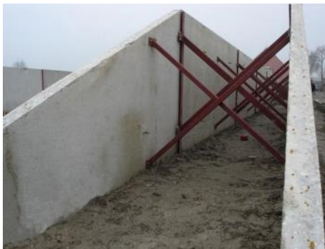
Mynd 8. Stífing milli veggja með stálstoðum að hollenskri fyrirmynd (Nielsen, 2009).
