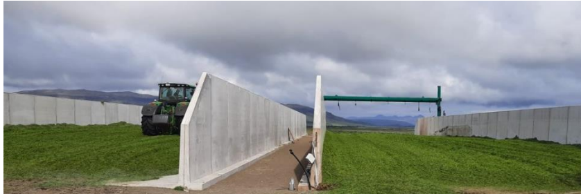
Mynd 7. Hollensk fyrirmynd með bil milli veggja. Oft er bilið fyllt með jarðvegi, sem dregur verulega úr fallhættu og gefur stuðning á vegg.
