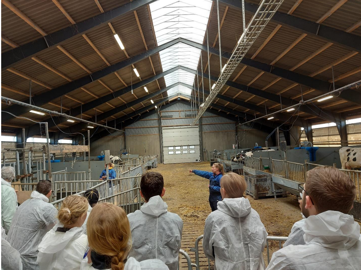
Mynd 13. Flex-fjósið þar sem hægt er að taka upp allar milligerðir og gólfefni og hagræða mv. þær rannsóknir sem eru í gangi að hverju sinni.
